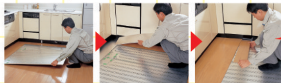
床の上にパネルを敷く 周囲を埋めるパネルを敷く 仕上げ材を設置
